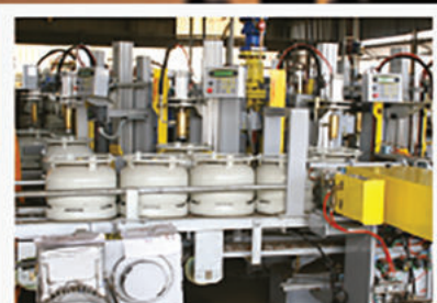
Un centre emplisseur d'une capacité de 300 tonnes / jour
